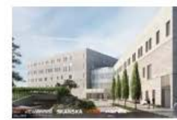
Oslo universitetssykehus HF Storbylegevakten (Finansiell leasing, i samarbeid med byggherre Oslobygg)
