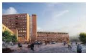
Oslo universitetssykehus HF Nye Rikshospitalet
