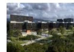
Oslo universitetssykehus HF Livvitenskapsbygget (Finansiell leasing, i samarbeid med byggherre Statsbygg)
