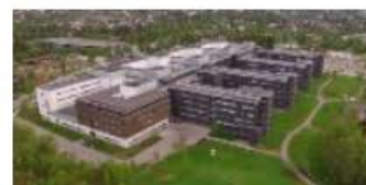
Akershus universitetssykehus HF Kreft- og somatikkbygg
